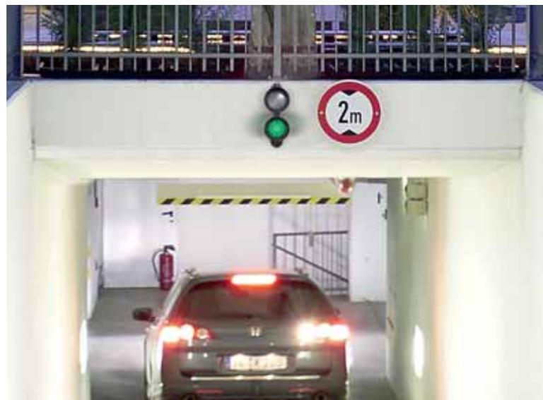
La regulación de la vía en combinación con lámparas de señalización regula la entrada y la salida de forma segura y fiable.
