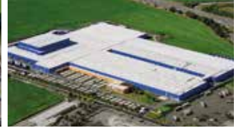
Hörmann KG Ichttershausen, Alemanha
