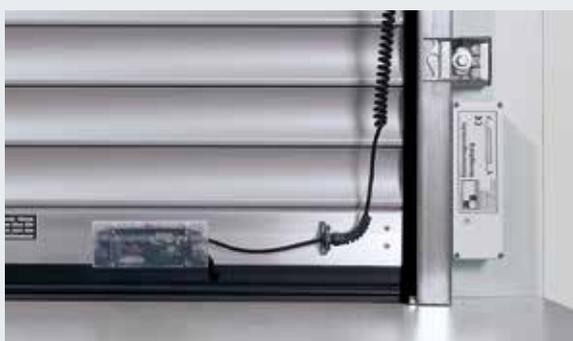
Os remates à prova de intrusão bloqueiam o perfil de inferior com as guias.
